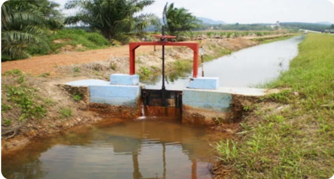
รูปที่ 5 ประตูน้ำเพื่อควบคุมระดับน้ำใต้ดินในพื้นที่ดินเปรี้ยวจัดของประเทศมาเลเซีย
