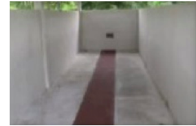
ห้องระบายอากาศ
